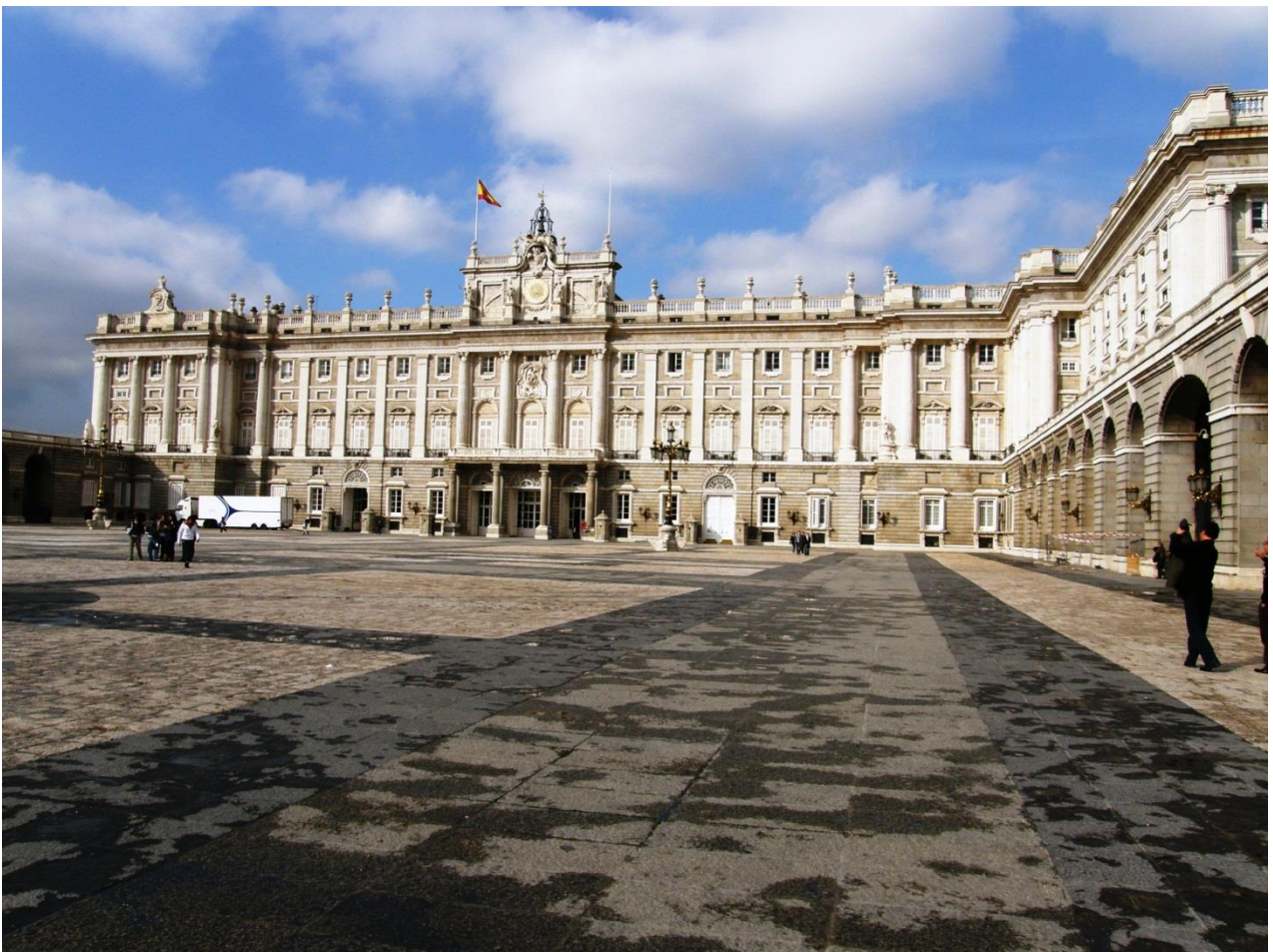
フェリーペ三世に謁見したマドリッド王宮（スペイン）
